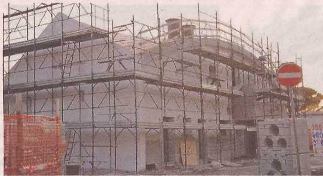
Una foto del cantiere nel 2012 dei lavori per la nuova cucina inaugurata poi nel maggio 2013 (Foto Gori)
